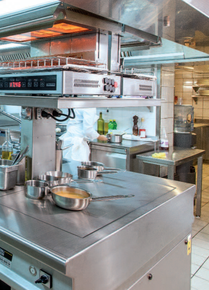
Menu System AG. A gauche, on voit le bain-marie, le multi-cooker à induction et une double salamandre éco. A droite, on voit le fourneau ainsi que la surface ouverte pour le dépôt de casseroles et l'installation de filtrage de l'huile des friteuses dans le bloc inférieur du fourneau.
